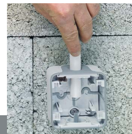
2/ Passage du tube dans l'embout.
